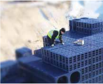
Wavin Q-Bic, il primo modulo per l'infiltrazione delle acque meteoriche, ispezionabile e pulibile
